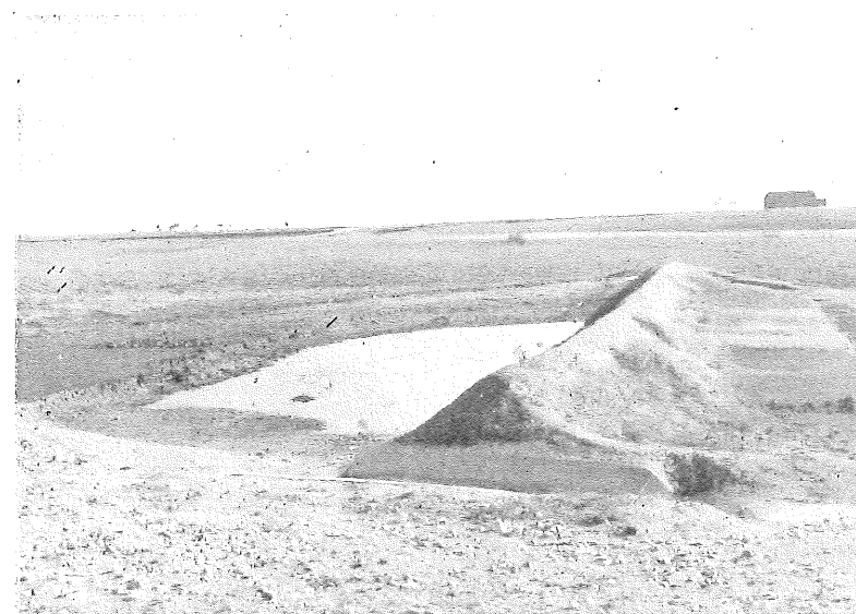
Sistema de recogida de aguas en Navalafuente, para abastecimiento de Talavera
